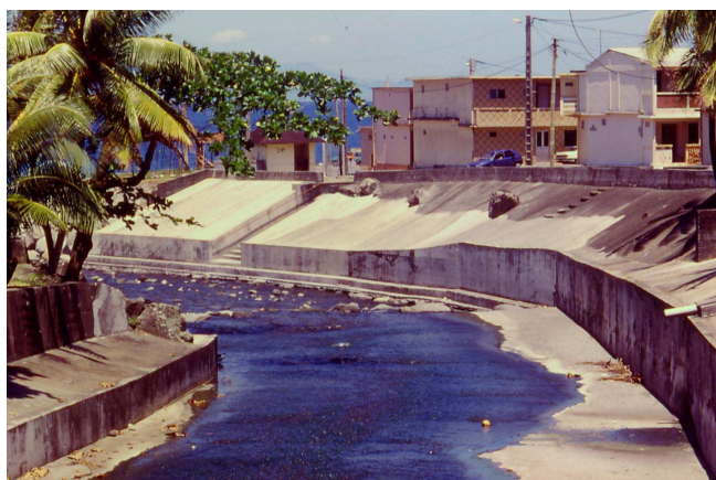
Photo 14 : Des soutènements localisés à proximité des habitations (endiguements à Grand-Rivière, Martinique). Cliché E. Bénito-Espinal.
