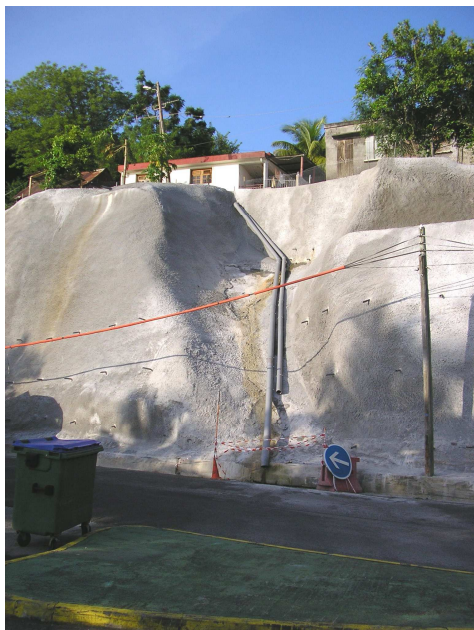
Photo 12 : Une « bétonisation » des pentes pour protéger des maisons (Prêcheur, Martinique) Cliché : F. Pagney Bénito-Espinal
