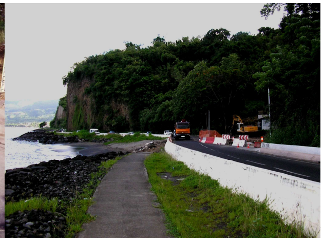
Photo 7 : Route littorale très exposée aux houles cycloniques et écoulements de versants, entre le Carbet et Saint-Pierre à la Martinique. Cliché F. Pagney Bénito-Espinal.
