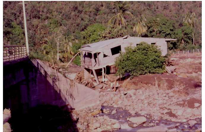
Photo 2 : Une maison en construction située dans le lit majeur de la Grande Rivière des Vieux Habitants (Guadeloupe), fortement endommagée par les crues au passage de l'ouragan Marilyn (1995). Aujourd'hui, 12 ans après la destruction de cette habitation, ce lieu est à nouveau construit au mépris de toute règle élémentaire de sécurité! Cliché E.Bénito-Espinal.
