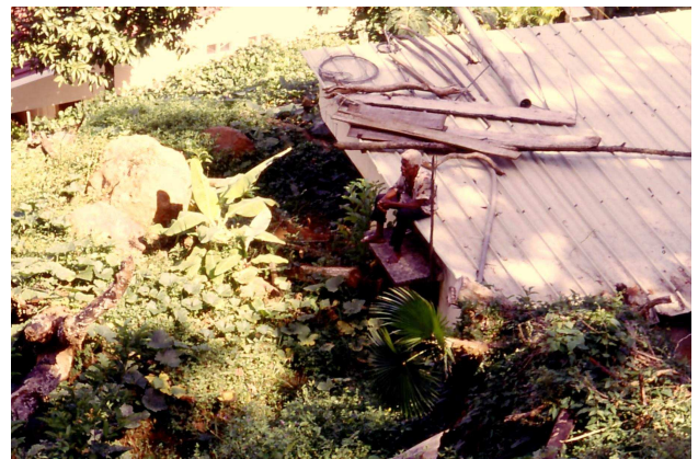
Photo 10 : Cet habitant, constate depuis le toit de sa maison, la coulée qui s'est arrêtée à sa porte, provoquée par les fortes pluies d'Iris (1995) sur les hauteurs du Lamentin à la Martinique. Cliché E. Bénito-Espinal.
